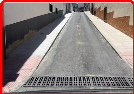
Actuación integral en la calle Andalucía
